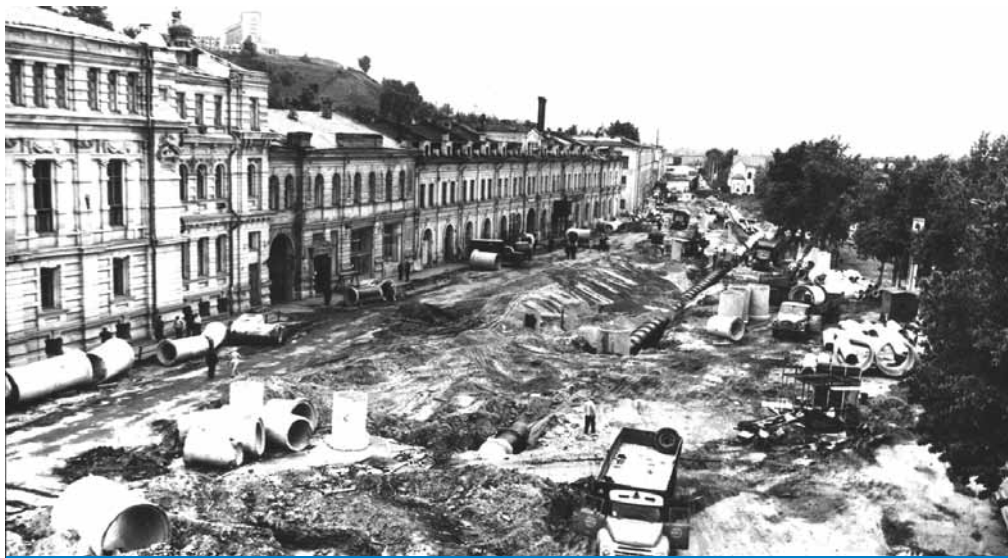
Рис. 1 Объем земляных работ при прокладке подземных коллекторов ливневой канализации
